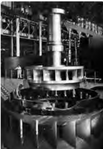
[8] 佐久間発電所用の10万kW立軸フランス水車
