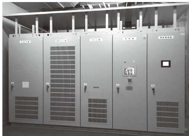
図6 | CHOP盤 (補助電源盤：最右側位置) CHOP盤と補機電源自給機能を搭載した補助電源盤の装置の外形を示す。
