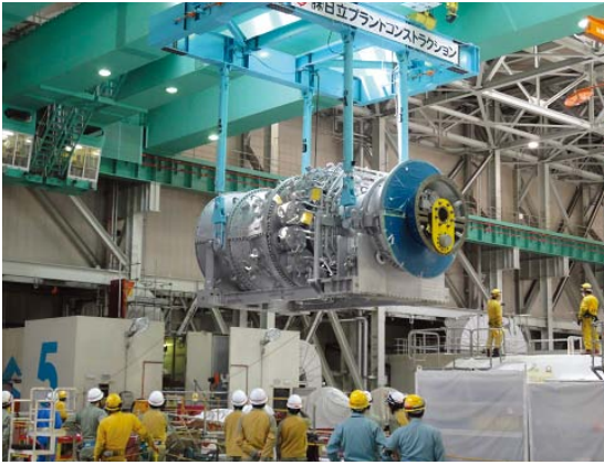
6 ガスタービン搬入作業の様子
