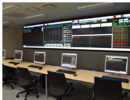
11 訓練施設(制御室)の内観
