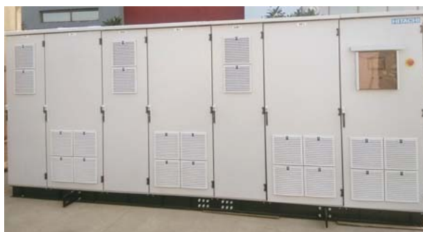
3 Hitachi Hi-Rel Power Electronics社と共同開発したDC1,500 V対応 太陽光PCS HIVERter-NP215iシリーズ
